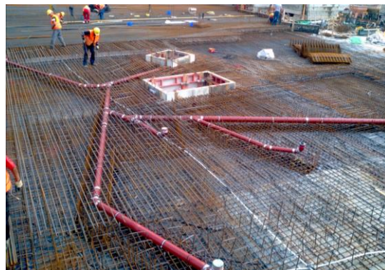
Grundleitungen in der Bodenplatte
