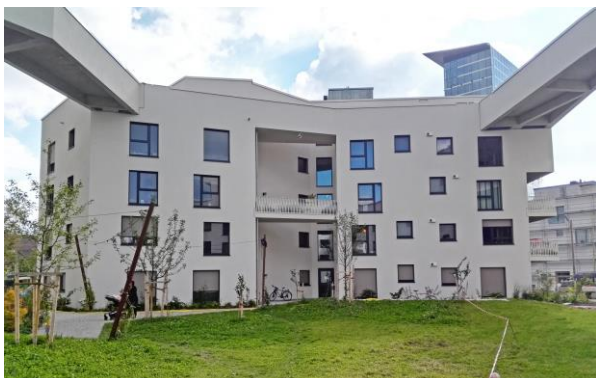
Teilansicht Gebäudekomplex mit Brücken
