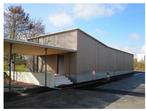
Tonstudio in Holzbauweise
