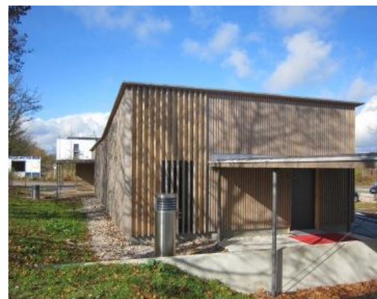
Außenansicht mit Abluftkamin
