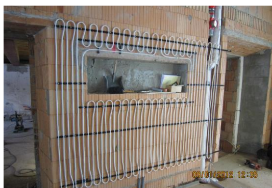
Wandheizung im Rohzustand
