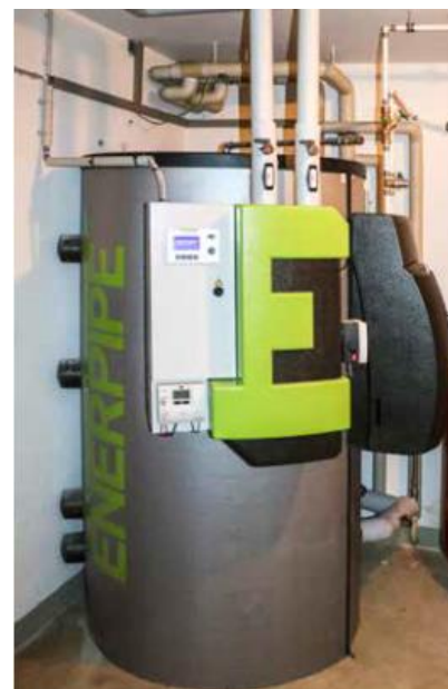
Übergabestation mit Speicher (Quelle: Fa. Enerpipe)
